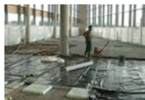
izolacja podłóg
