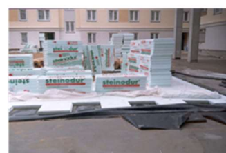
izolacja drogi pożarowej
