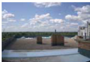
izolacja dachu płaskiego
