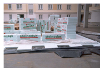
izolacja drogi pożarowej
