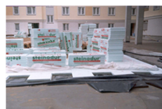
izolacja drogi pożarowej
