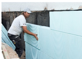
izolacja fundamentów, ścian piwnic, cokołów
