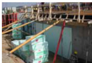
izolacja ściany fundamentowej
