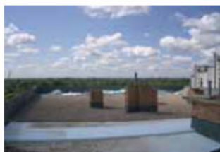
izolacja dachu płaskiego
