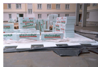
izolacja drogi pożarowej
