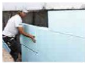
izolacja fundamentów, ścian piwnic, cokołów
