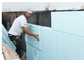
izolacja fundamentów, ścian piwnic, cokołów
