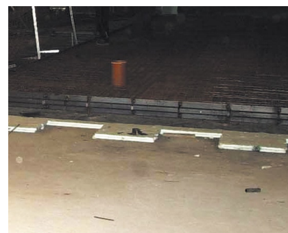
Fot. 2. Ocieplenie podłogi na gruncie
