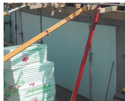
Fot. 1. Ocieplenie fundamentu
