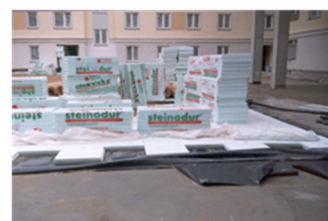
izolacja drogi pożarowej
