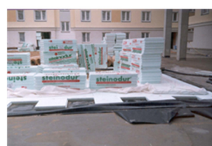
izolacja drogi pożarowej
