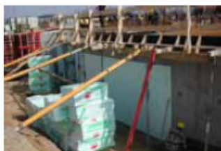
izolacja ściany fundamentowej
