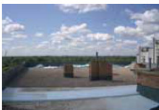
izolacja dachu płaskiego
