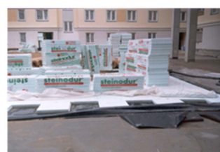
izolacja drogi pożarowej
