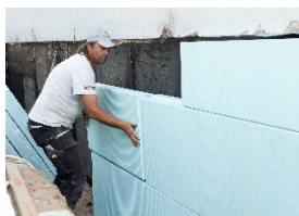
izolacja fundamentów, ścian piwnic, cokołów
